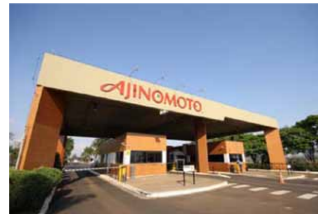
Acesso à Unidade de Limeira , a primeira unidade industrial da Ajinomoto no Brasil.
