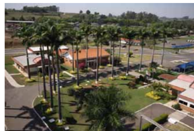
UNIDADE DE LARANJAL PAULISTA , produtora de glutamato monossódico para uso industrial. Os resíduos são aproveitados na produção de fertilizantes agrícolas.
